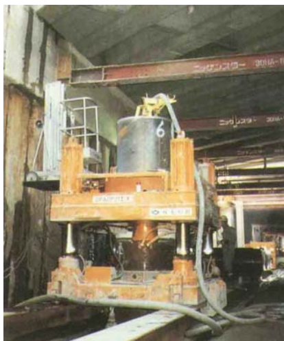
圖 10.1-3 日本低淨空鋼管樁SPACE21工法 [47]
