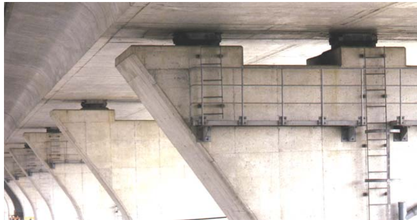
圖 8.9-1 支承檢測維修平台
