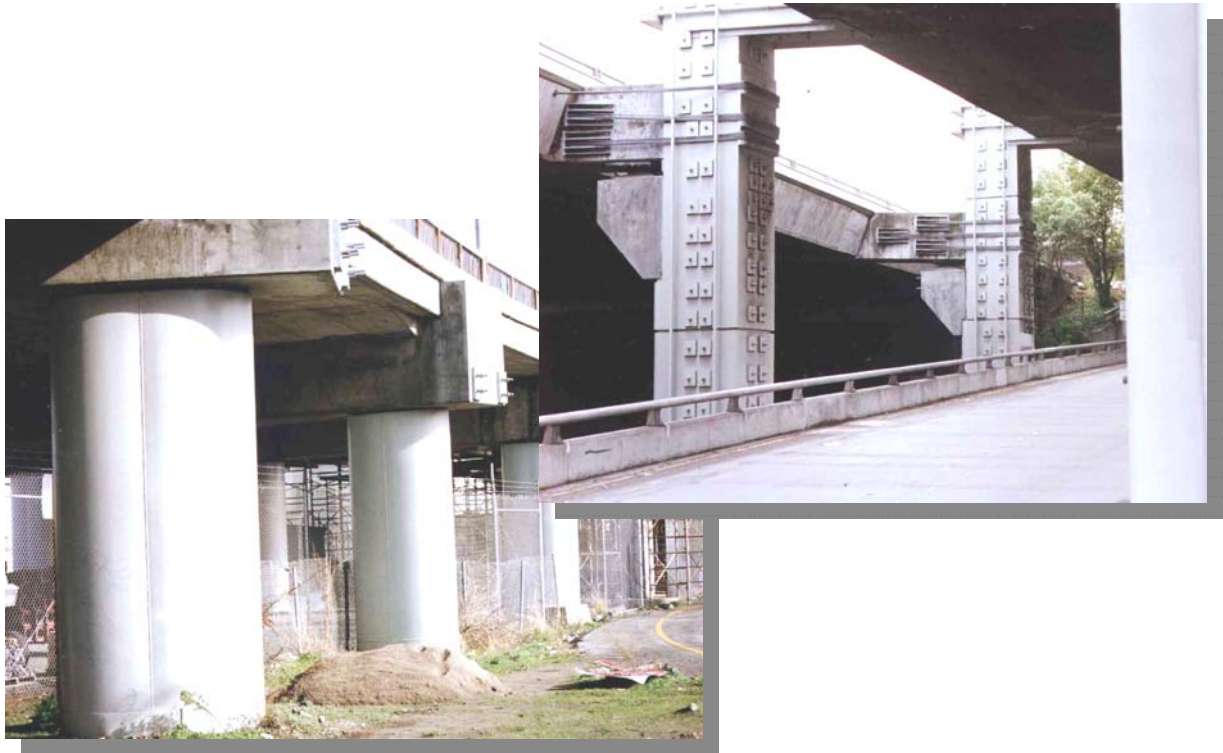
圖 4.1-3 鋼板包覆補強工法
