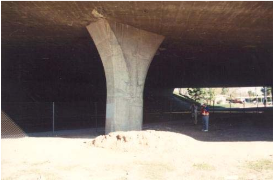
圖 6.1-11 美國北嶺地震造成之土壤液化噴沙情形 (資料來源：美國 NCEER)
