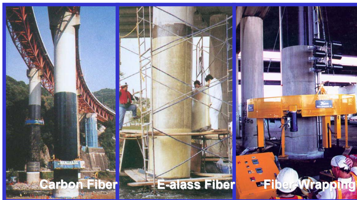
圖 4.1-5 FRP包覆補強工法
