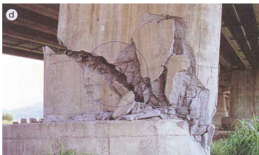
圖 6.1-6 RC橋柱之剪力破壞(一) [16]
